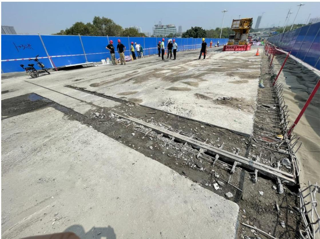
设监理有限公司。2021年春节后，广州大道（天河北路-洛溪大桥）快捷化改造系统工程-洛溪大桥拓宽工程项目进入对洛溪大桥旧桥的改造施工阶段，事发时该项目正在进行洛溪大桥旧桥附属管线拆除和破除旧桥伸缩缝周边混凝土的施工作业。涉事车辆为鄂 J27108 桥梁检测作业车，由保利长大工程有限公司第一分公司向广东振邦机械设备租赁有限公司租赁，是用于洛溪大桥旧桥改造施工的重型非载货专项作业车。广东振邦机械租赁有限公司派出本单位驾驶员冼某成负责驾驶该车辆，桁架操作员谷某奇负责操作车上的桁架收放工作，该桥梁检测作业车为施工单位拆除洛溪大桥旧桥翼板位置的支架和废旧管线等作业提供一个长 22 米、宽 1 米可伸缩的铝合金长方形作业平台。
