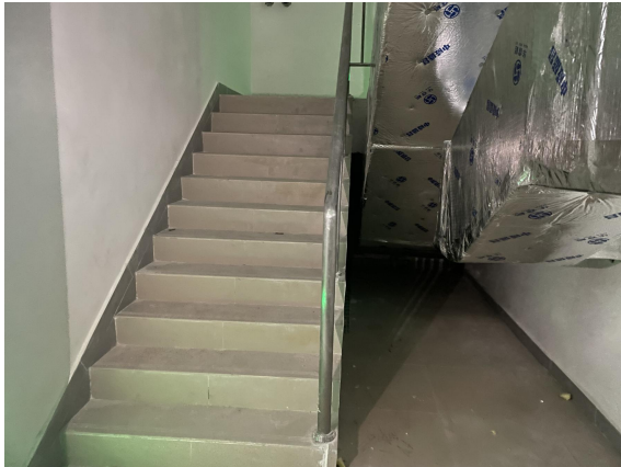
图 9 2#消防楼梯 (勘查照片)
