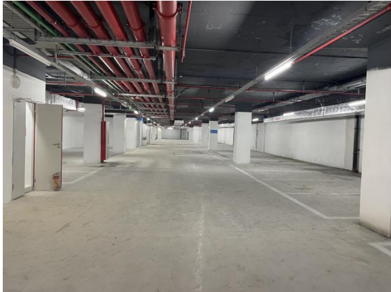
图 7 负 3 层概况（勘察照片）
