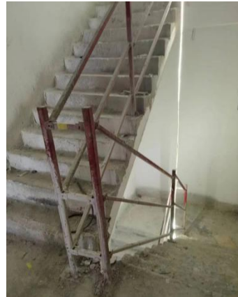
图 10 2#消防楼梯 (施工期间照片)
